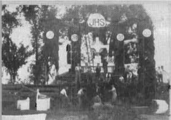
Toujours les mêmes à l'oeuvre
