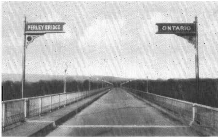
Le pont interprovincial Perley avant les modifications
