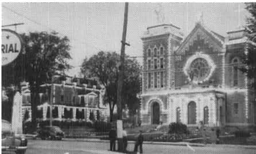
(Photo du presbytère agrandi, au temps du chanoine Gascon et du chanoine Guindon. Edifice qui a rappelé tant de souvenirs et qui, malheureusement, a été démoli il y a quelques années pour faire place à la Caisse populaire.)
