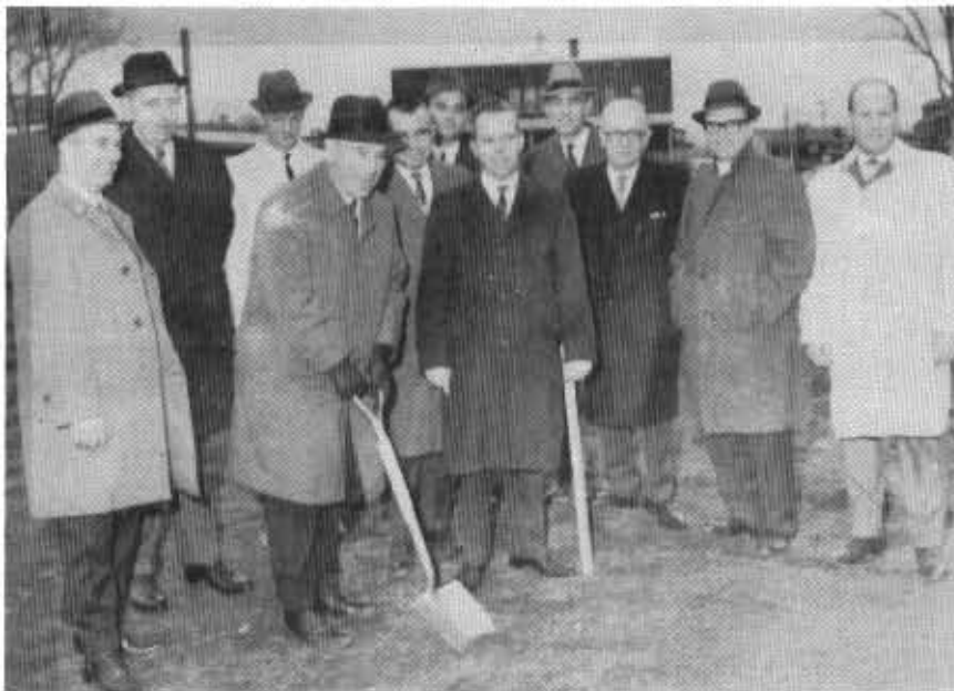
Première pelletée de terre soulevée par le Ministre L.-P. Cécile lors de la construction de l'école Paul-VI.
