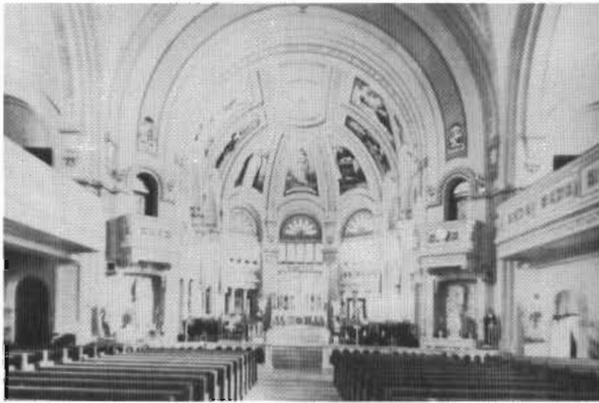
Intérieur de la nouvelle église avec le sanctuaire et l'autel. A noter les décorations qui existaient autrefois, les changements qui ont modifié l'aspect actuel du sanctuaire.
