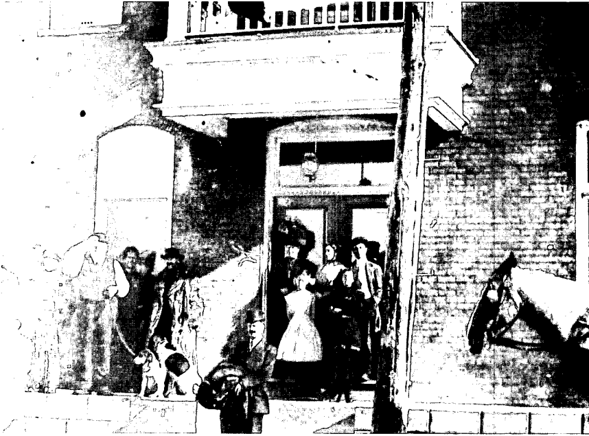
La façade de l'hôtel Lachapelle qui a brûlé en 1919.
