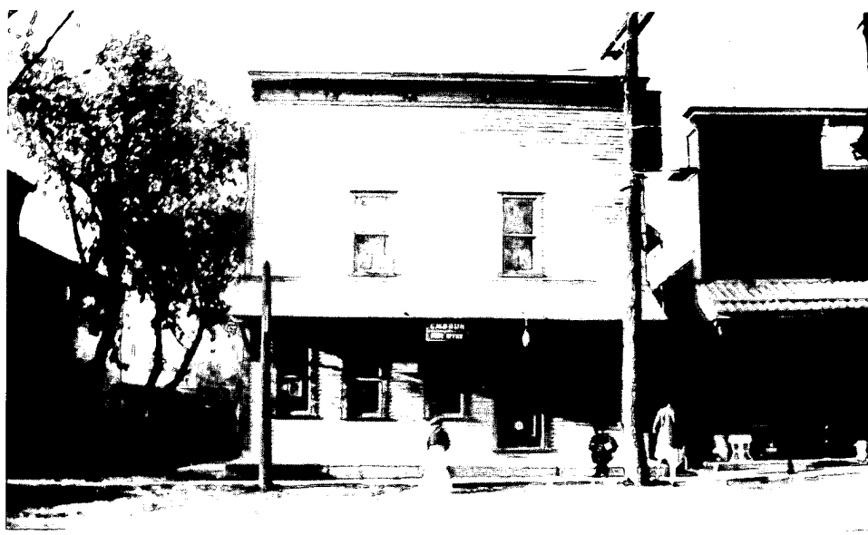
Cet édifice construit en 1896 servait de bureau de poste et de central téléphonique avant 1932. À droite, on remarque le magasin Maheu et à gauche l'hôtel Debonville. Ces trois bâtiments seront la proie des flammes en 1932. Source : Armand et Desanges Bruyère
