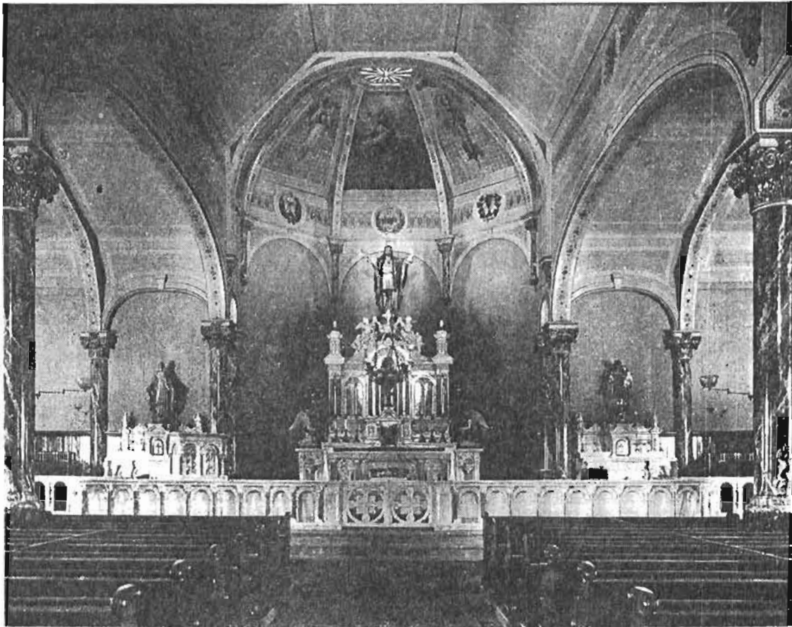
Intérieur de l'Église après restauration en 1921.
