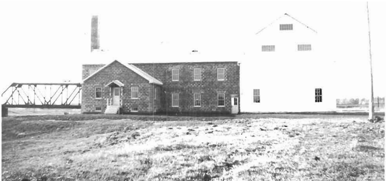
En 1940, on construisit une usine qui convertit le lin en filaments. Vue d'ensemble de la linerie avant qu'on y ajoute un 3 e étage et une cheminée plus longue. A gauche, la cheminée de 85 pieds et l'entrée principale; vers la droite, l'entrée des employés et la grange où l'on entreposait les récoltes de lin. Cette coopérative de lin était située sur l'emplacement actuel de la compagnie Capital Box of Ottawa.
