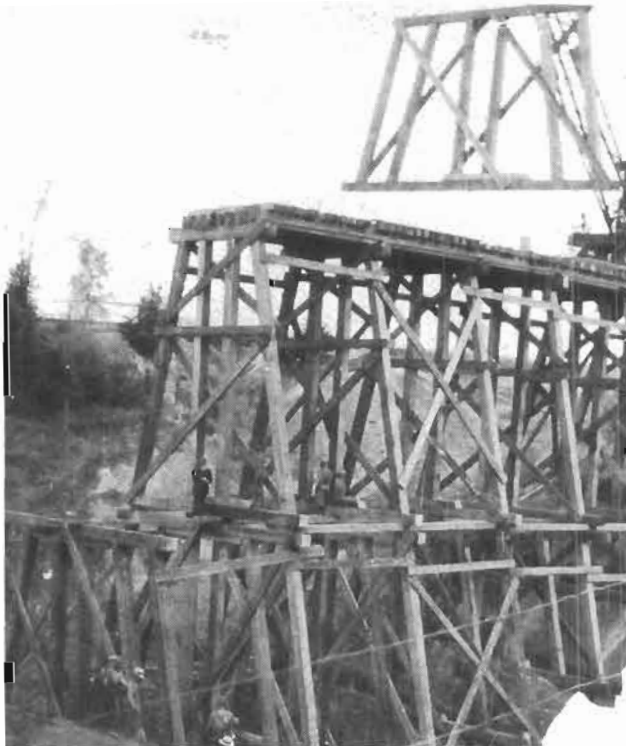
Voici l'échafaudage qui a servi à installer et fixer à demeure le pont qu'empruntent encore aujourd'hui les trains qui passent à Casselman.
