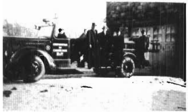
L'acquisition en 1945 d'un camion avec pompe à eau, échelle et beaucoup de place pour les pompiers. On remarquera les chaînes de traction sur les pneus à l'arrière. Au-dessus du pare-brise, une sirène...enfin tout ce qu'il fallait en 1945.
