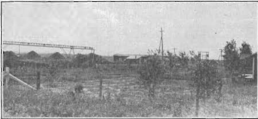
Industrie de la Terre-Noire—(Vue générale).
