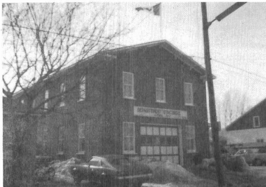
Hôtel de ville avec poste d'incendie au rez-de-chaussée
