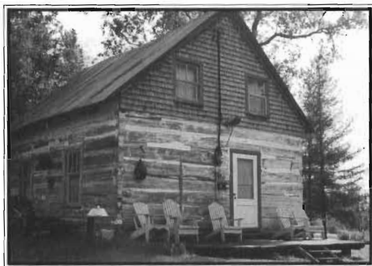
Maison construite par M. Charles Alexandre Rivers dans les années 1870 environ; arrière-grand-père de J. Jacques Rivers. Cette maison est construite sur le Boundary Road nord, côté est
