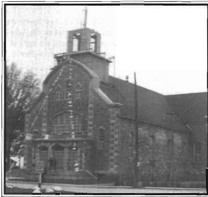
La reconstruction de l'église
