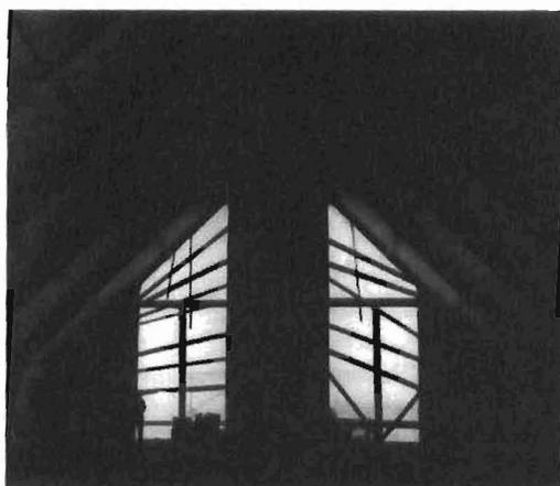
Les poutrelles retenant les poutres du toit en place sont installées, le sanctuaire surélevé est déjà bien visible ainsi que la forme des fenêtres de chaque côté de l'autel.
