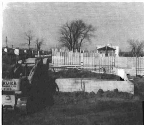
Le béton a été coulé et on procède au remblai des fondations.
