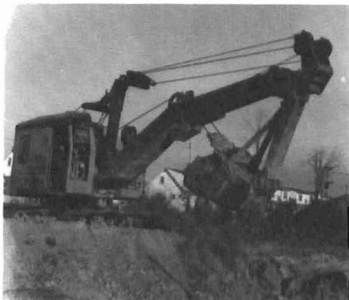
Le travail plus précis de creusement se fait avec une pelle mécanique.
