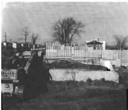
Le coffrage des fondations est déjà presque terminé. On y coulera sous peu le béton.
