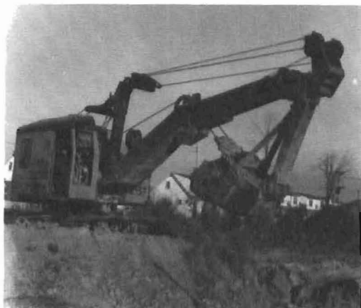
Le travail plus précis de creusage se fait avec une pelle mécanique.
