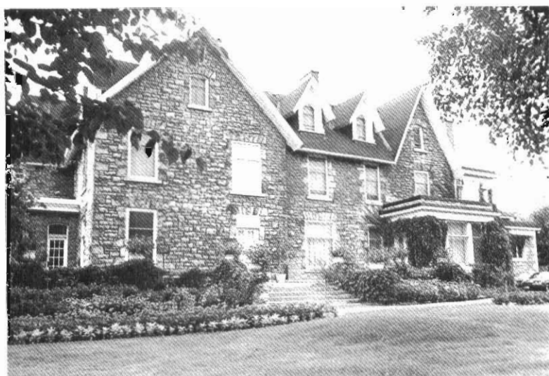
395 Laurier est, construite en 1871 où vécut l'Hon. Cauchon de 1875 à 1877 (maintenant l'Ambassade de Belgique).
