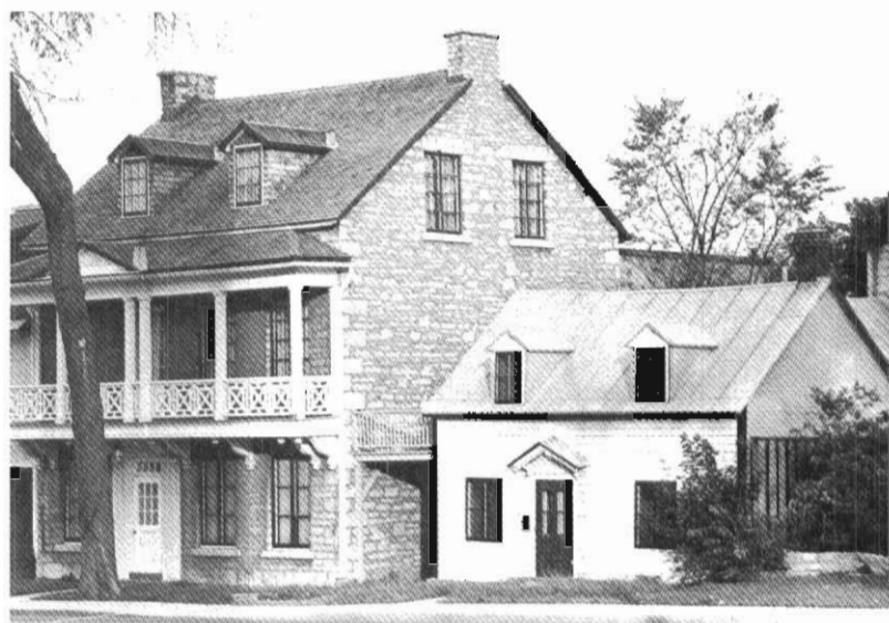
142, rue St. Patrick -- Maison de pierre, dite maison Valade-Lemay, construite vers 1862; 138, rue St. Patrick -- Maison de bois construite vers 1840, habitée par P. Bastien et F. Rochon.
