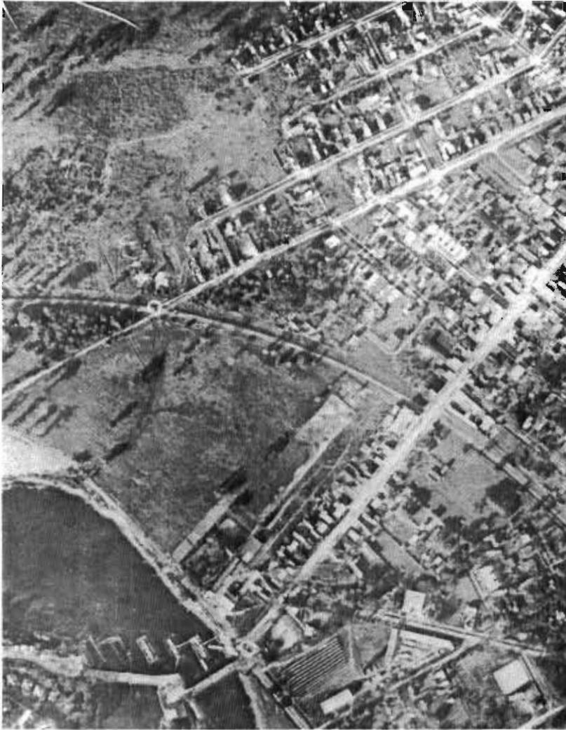
Photo aérienne de la construction du nouveau pont Cummings, prise le 8 octobre 1920. Dans le coin inférieur droit on voit l'ancien pont qui joignait l'île Cummings aux rives de la rivière Rideau et les piliers de béton qui supporteront la nouvelle structure, inaugurée en 1921. Cette photo nous donne également une vue d'ensemble des édifices qui jalonnaient le chemin de Montréal et les rues secondaires d'Eastview à cette époque. (Photo APC)
