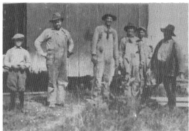
On démolit la vieille grange. Demolishing the old barn on Félix Pinsonneault's farm: Sylvio Pinsonneault, Albert Quenneville, Félix (Sylvio's father), Sam Guilbeault, Alfred Moison and Louis Désilets.
