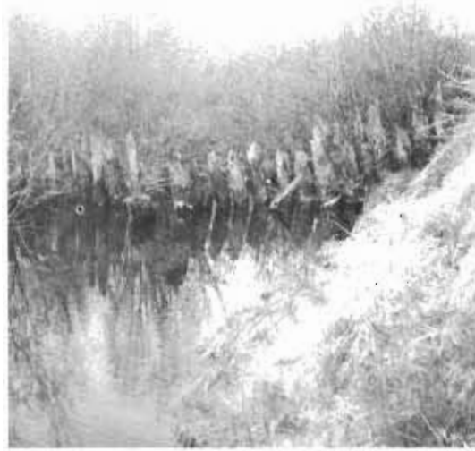
Ruines du barrage du Moulin "Imperial"
