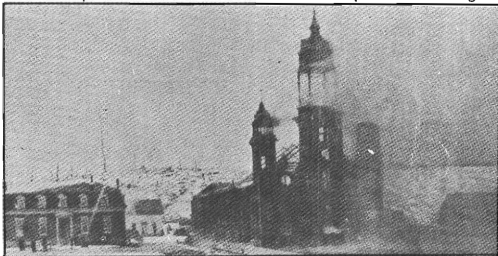
ÉGLISE DÉTRUITE PAR LE FEU LE 23 MARS 1894.
