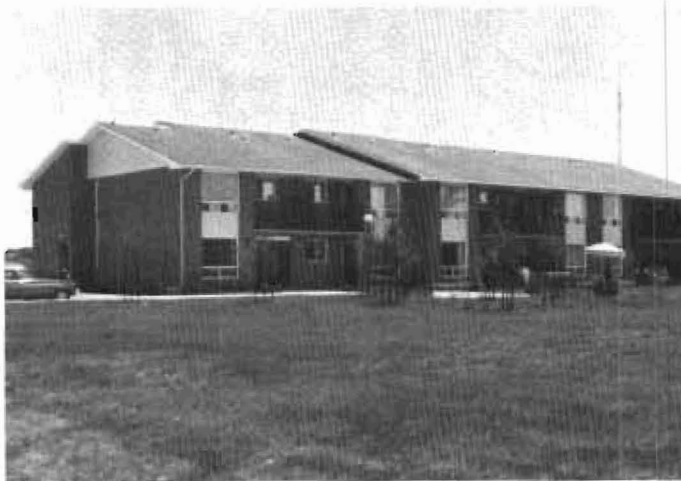
Côté ouest de la résidence
