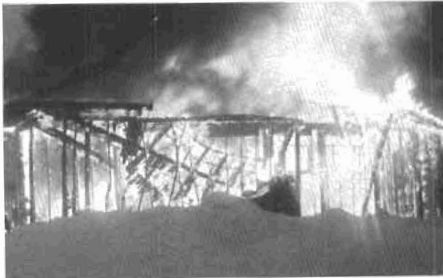
Le 12 février 1976, le rêve d'une clinique médicale est soudainement anéanti lorsqu'un incendie détruit complètement l'édifice en construction
