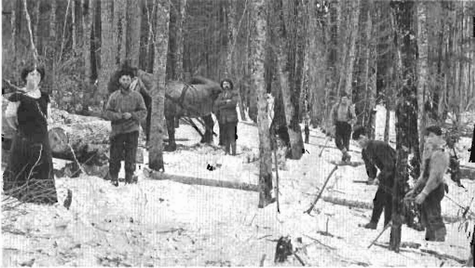
Au chantier dans les premières années
