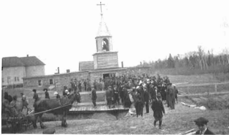
Soubassement: 1914-1928 A l'arrière plan: presbytère qui a servi de première chapelle, de 1905-1914
