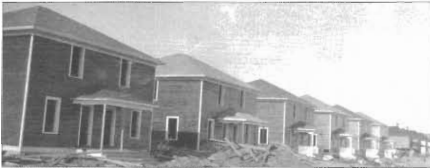
1920: Houses under construction on 4 th Street / Maisons en construction sur la 4 e rue
