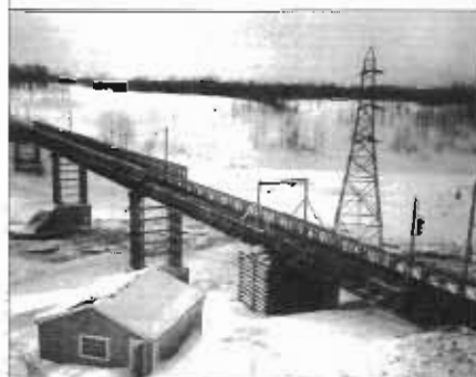
Jan. 4, 1957: Bailey Bridge
