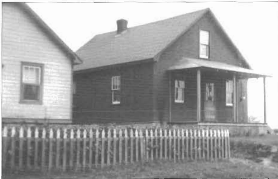
In 1946, Hazel Welch operated a switchboard for Northern Telephone out of her residence at 228 Main Street. / En 1946, Hazel Welch gérait un central téléphonique dans sa résidence, au 228 de la rue Main, pour la compagnie Northern Telephone.
