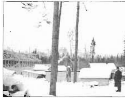
c.1910-15: Early construction view of Jacksonboro (Ontario Archives) / Aperçu des débuts de la construction à Jacksonboro (Archives de l'Ontario)
