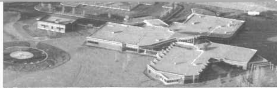
Aerial view of the 5 th hospital. The official opening was held Nov. 22, 1988. Vue aérienne du 5 e hôpital. L'ouverture officielle a eu lieu le 22 nov. 1988.
