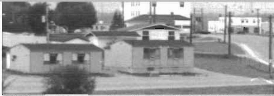
1989: These buildings were on the north end of 6 th St. L-R: dentist's office, public library. / Ces bâtiments étaient à l'extrême nord de la 6 e rue. G-D: cabinet du dentiste, bibliothèque publique.
