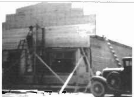
Construction of a store in Unionville Construction d'un magasin à Unionville
