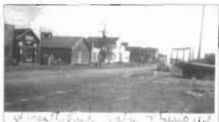
1943: Main Street, looking east. Rue Main, donnant vers l'est.
