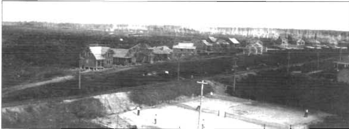
c.1927: A new subdivision under construction along 5 th Street. Tennis courts are in the foreground. Une nouvelle subdivision en construction le long de la 5 e rue. On voit le terrain de tennis en avant-plan.
