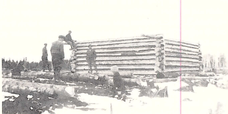
Construction d'un camp en bois rond.
