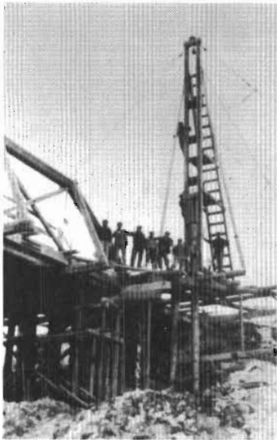
Travaux de construction.
