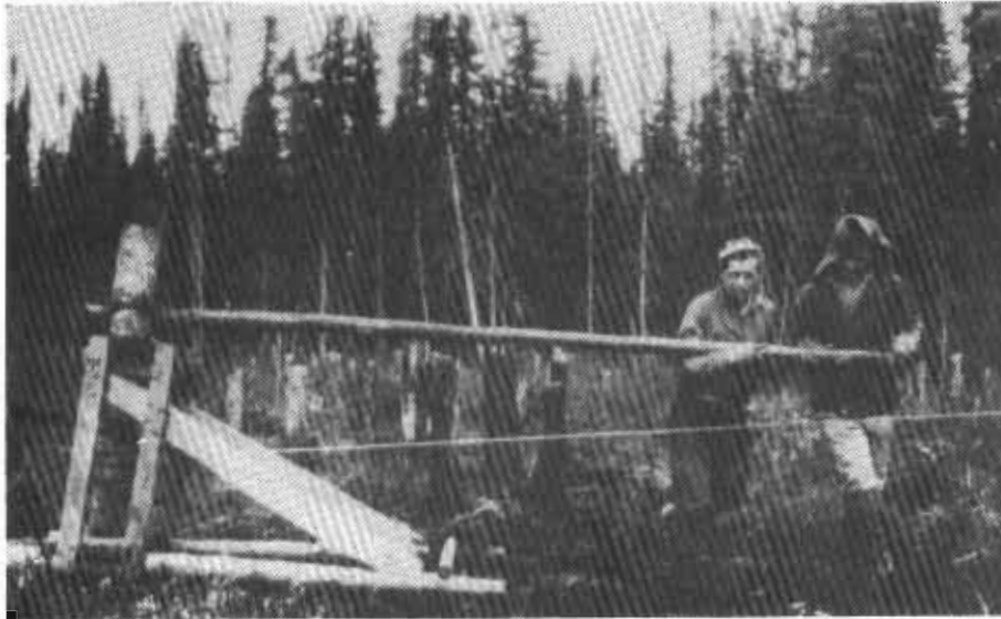
L'arrachage des souches pour la construction du chemin entre les lots 6 et 7 de la concession XII. L'arrache-souche appartenait à M. Jacob Ediger. A gauche: John Newfeld et John Enns.
