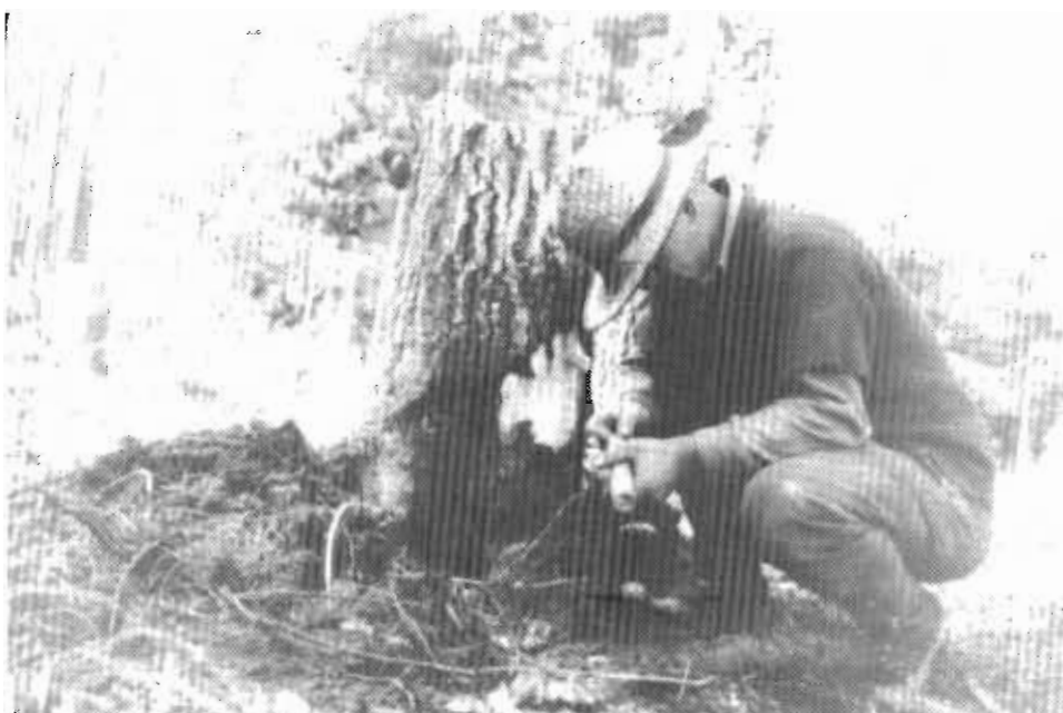
Le dynamitage des souches de peupliers fait par John Enns en 1930 afin de procéder à la construction de la route 11, entre les lots 6 et 7, concession XII, canton de Barker.
