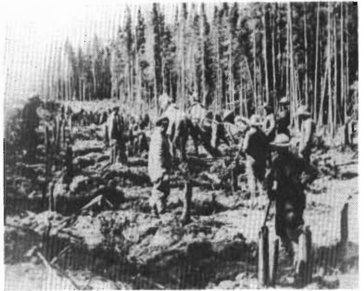
Construction du chemin à Reesor entre les lots 6 et 7, concession II et III.
