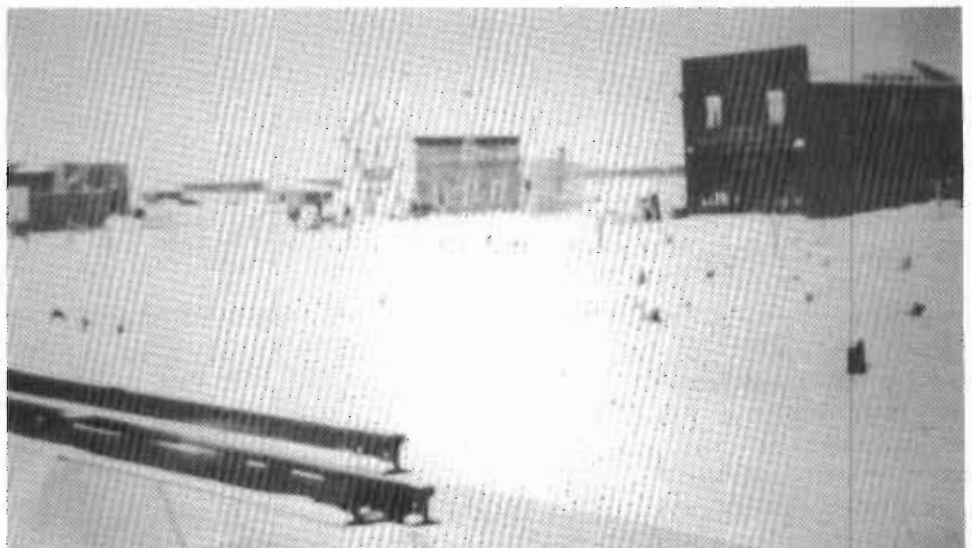
La rue King en 1925. Remarquer les souches et le chemin non déblayé.
