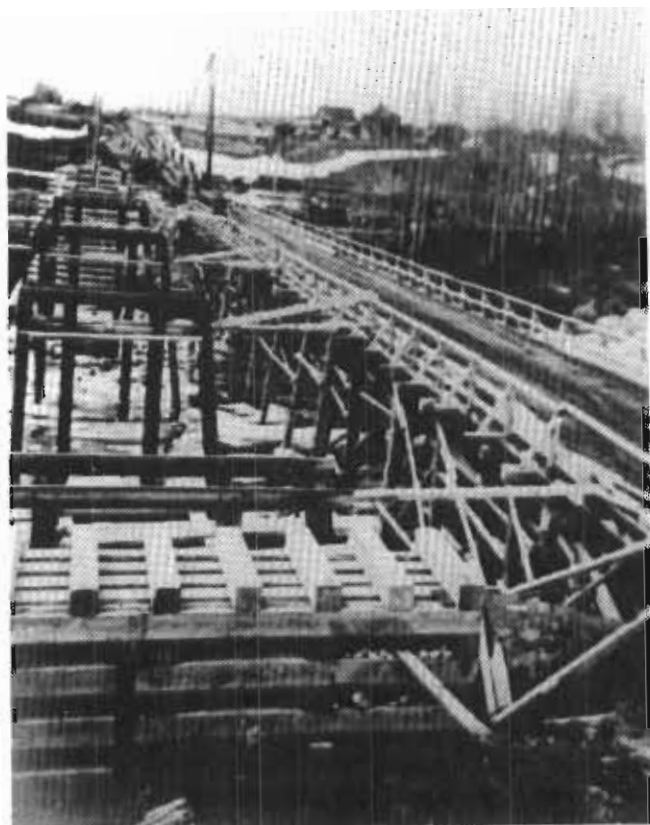
Construction du deuxième pont. (printemps 1948, les glaces descendent).
