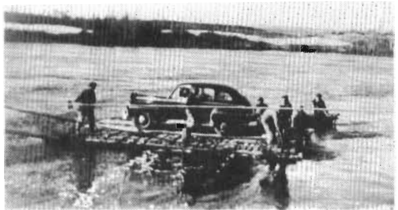
Au début de l'été 1947 après que le pont fut emporté par les glaces et que l'eau eu baissé, Orlando et Rolland Chabot ont fabriqué un chaland pour traverser les autos d'une rive à l'autre de la rivière. Il coûtait $5.00 pour chaque voiture traversée.
