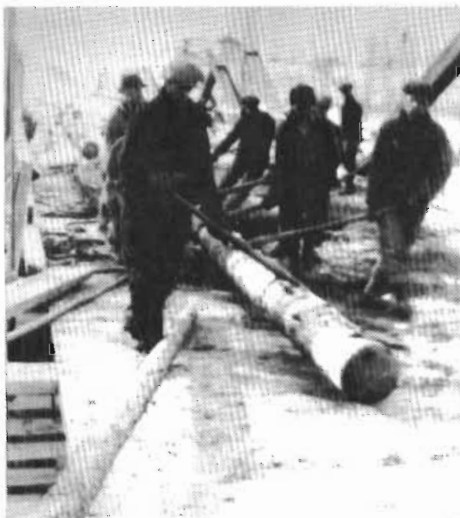
Construction du pont à Mattice en 1934. Albert Dupuis, Ovida Guenette et Louis Fillion.
