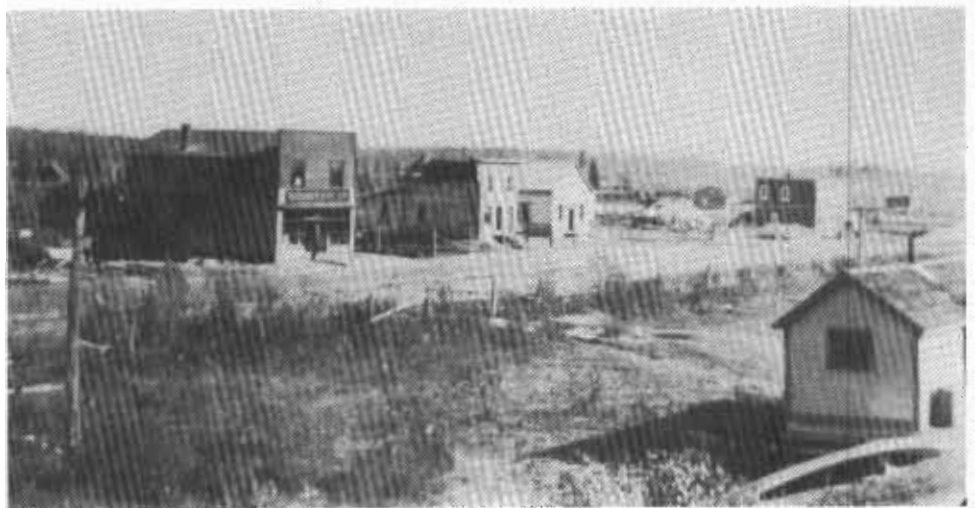
La rue King de Mattice vers 1923. On peut voir la petite cabane des moteurs pour le chemin de fer.
