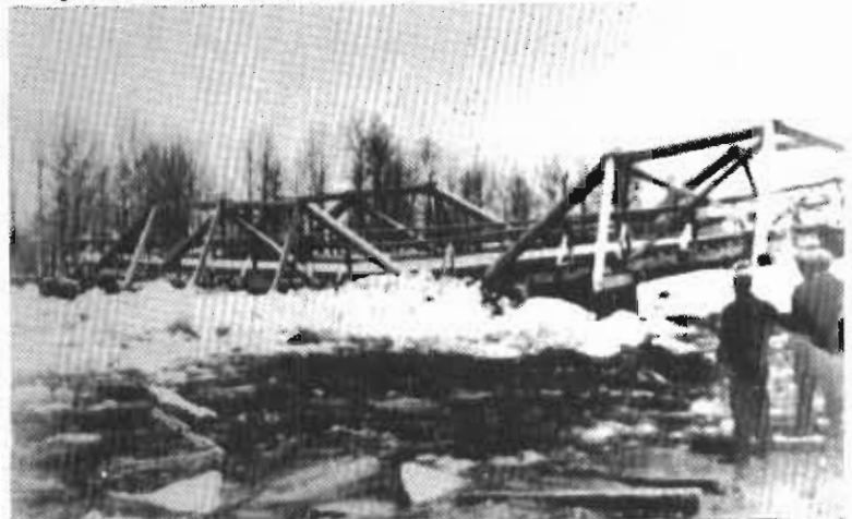
Le pont était sur le point de céder à cause des glaces en 1947.
