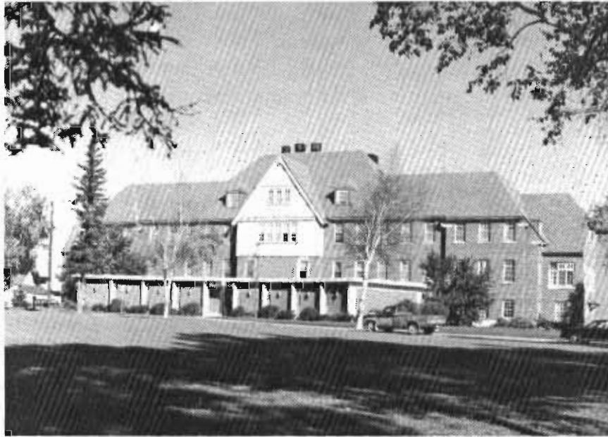
L'hôpital Sensenbrenner ouvert en 1929 et remplacé par un nouvel édifice en 1987. Photo : Archives de Kapuskasing.
