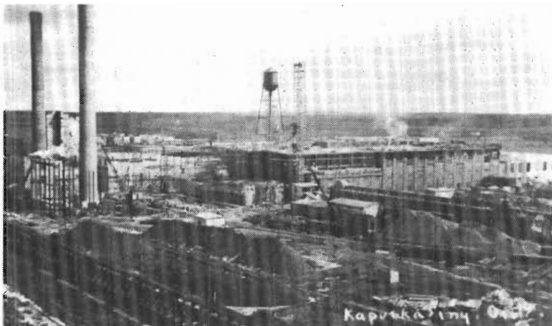
Construction de l'usine de la compagnie Spruce Falls en 1926. Photo : Archives des oblats.
