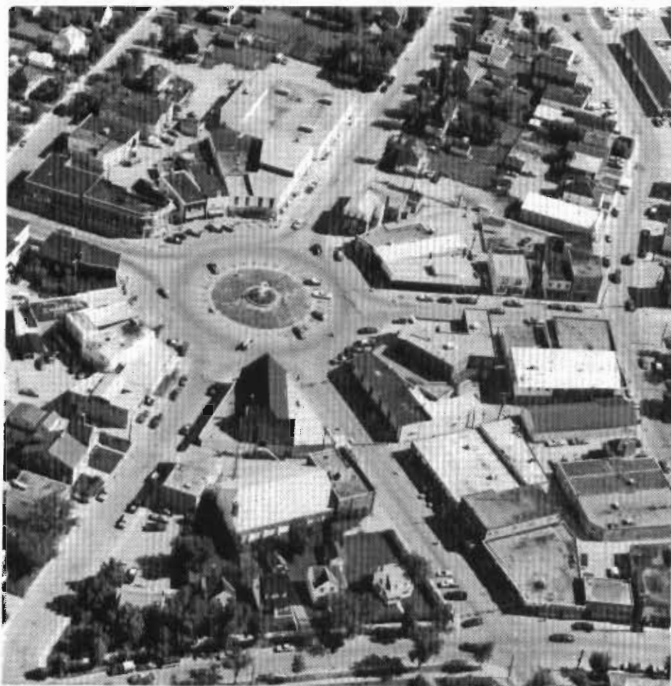
Vue du rond-point et des environs. Photo : Archives de Kapuskasing.
