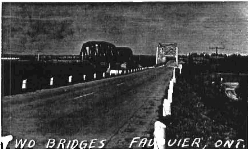
Vue des deux ponts.
