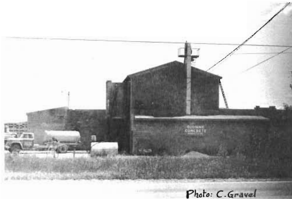
Manufacture de bloc de béton
