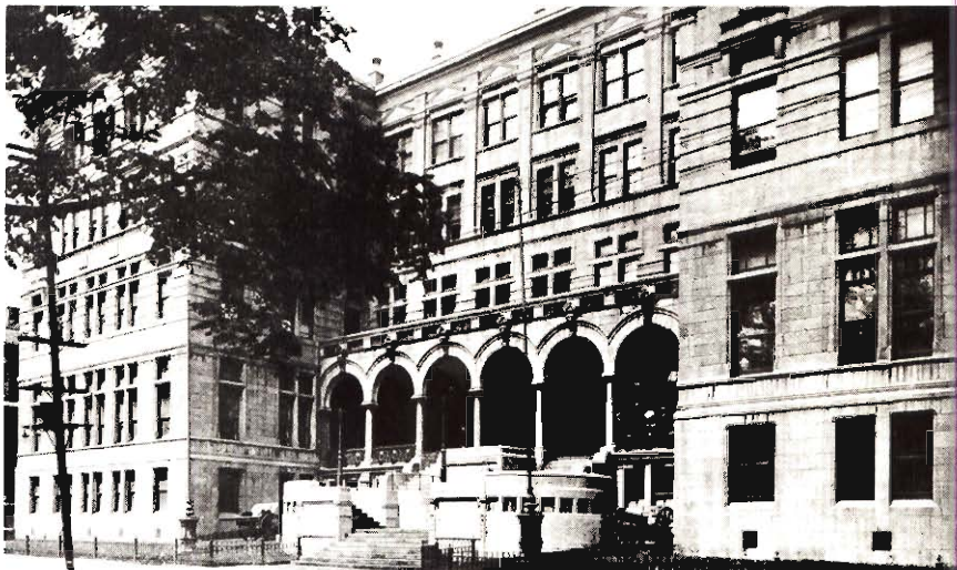
L'Université de Montréal, immeuble central de 1895 à 1942.
