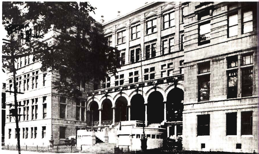
L'Université de Montréal, immeuble central de 1895 à 1942.
