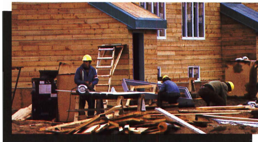
Duplex en construction à Eastmain. Photo: Bernard Beaupré
