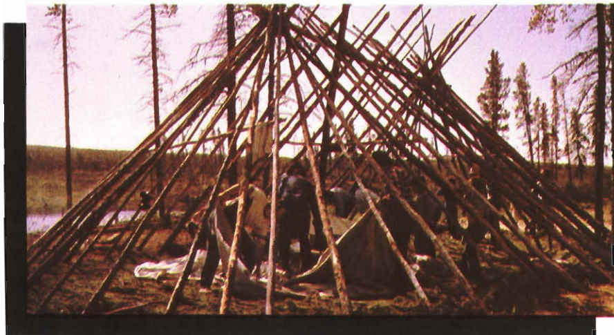
Construction d'un camp temporaire pour trente personnes qui dormiront confortablement sur un épais plancher de branches d'épinettes.
