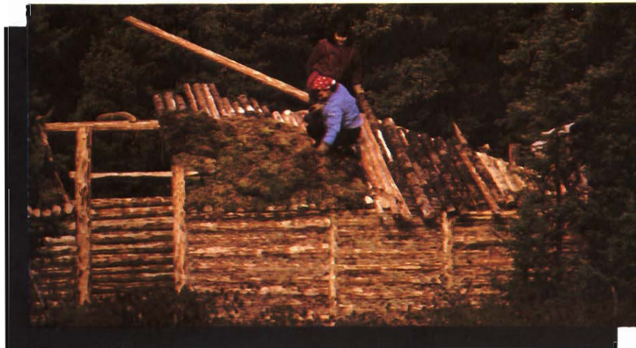
On recouvre le toit de mousse lors de la construction d'un camp de chasse qui pourra abriter trois ou quatre familles cries.
