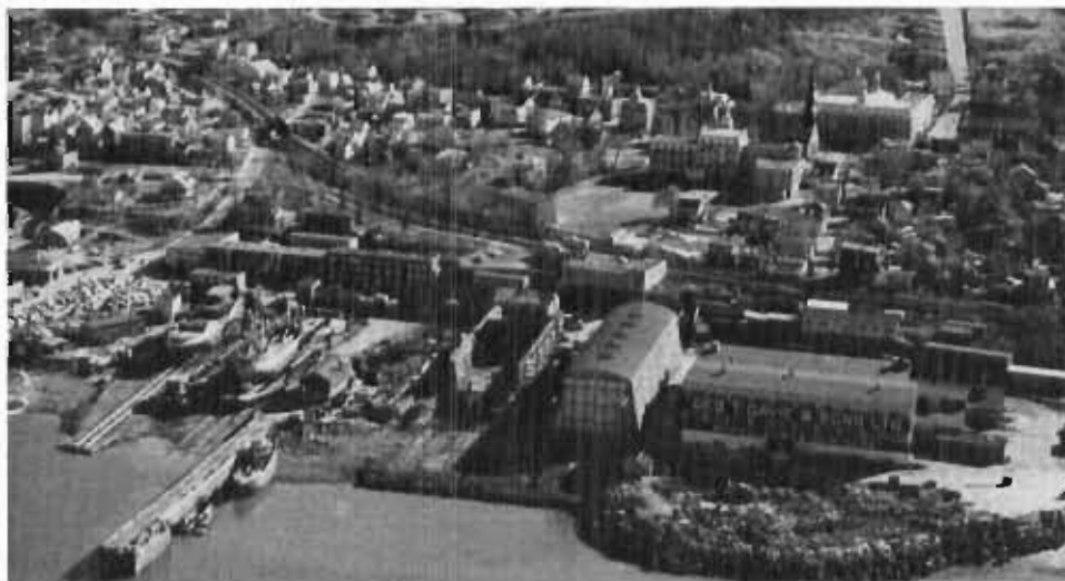
Vue d'ensemble du "Petit" chantier de Lauzon vers 1966 (coll. Monique Laflamme).
