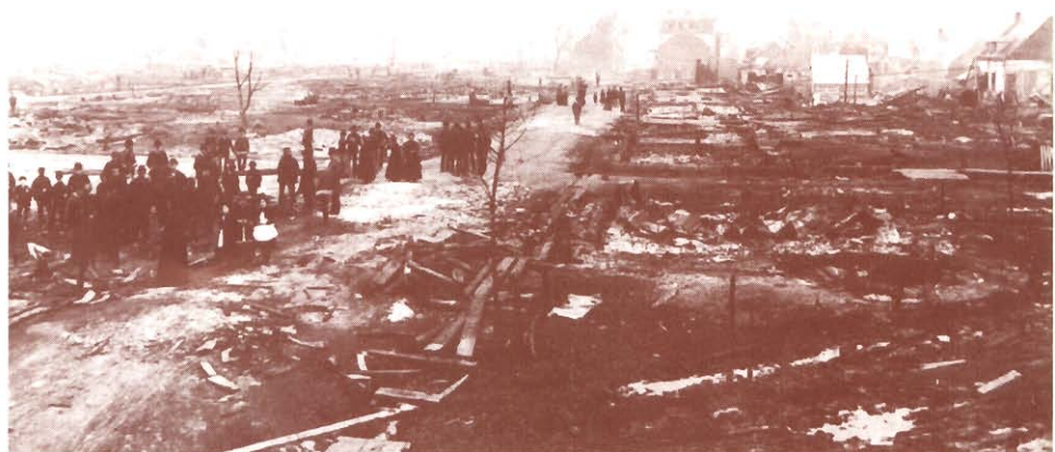
Incendie du quartier Saint-Sauveur (Québec) en 1889. ANQ, Coll. initiale
