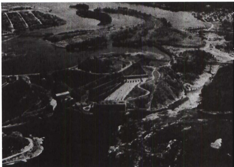
Barrage de la Shawinigan Water and Power Co. à Shawinigan en 1929
