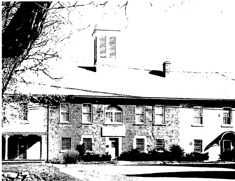
Palais de justice de l'Original, construit en 1824
