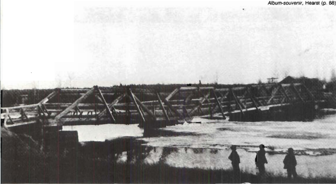
11. Pont sur la rivière Mattawishkwia, 1920.
