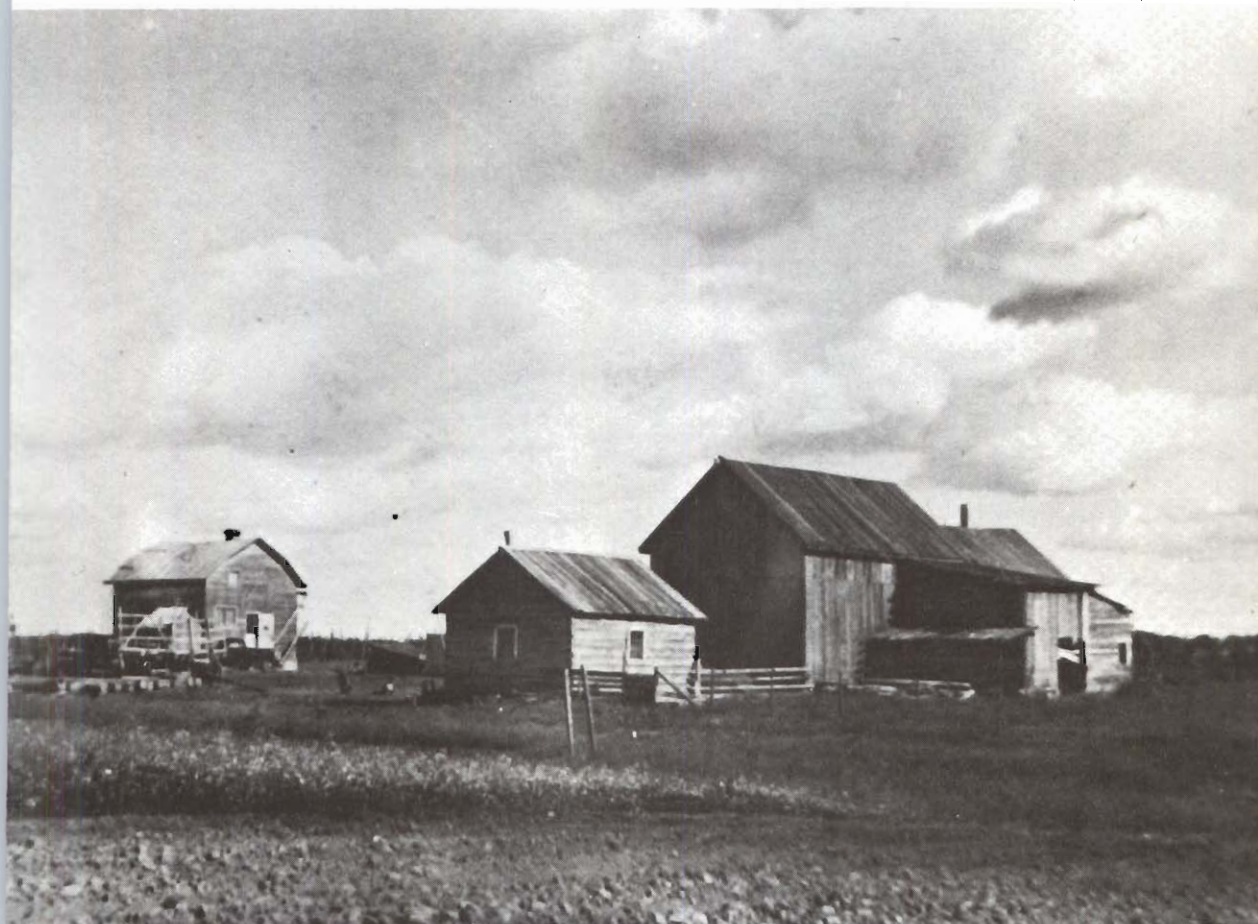
37. Maison et bâtiments de ferme, Norembega, 1940.
