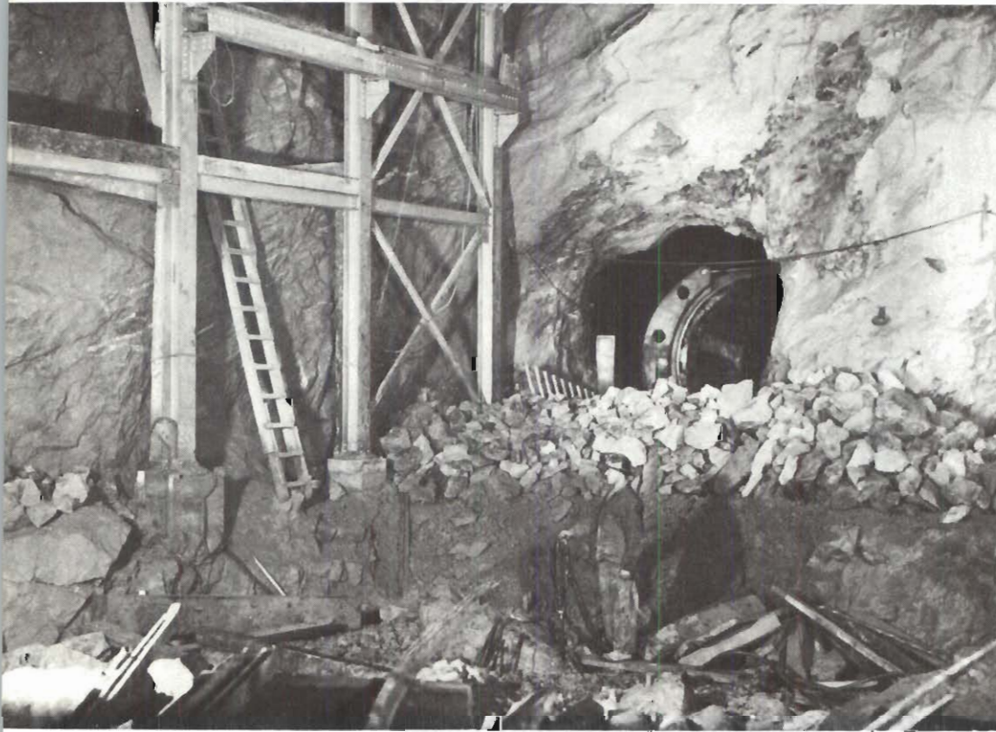
91. Mise en chantier d'installations souterraines à la Dome Mines , South Porcupine, 1936.
