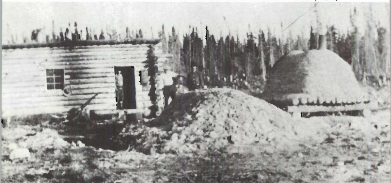
30. Habitation et four à pain de Joseph Côté, Norembega, 1917.
