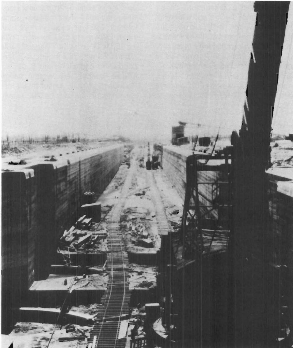
8. Construction du canal Welland. Vue de l'écluse n° 8, depuis le pont n° 19, 30 mars 1928.
