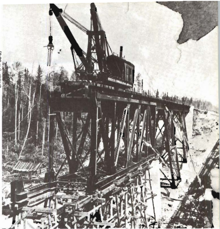
20. Pont ferroviaire sur la rivière Frederickhouse, env. 1913.
