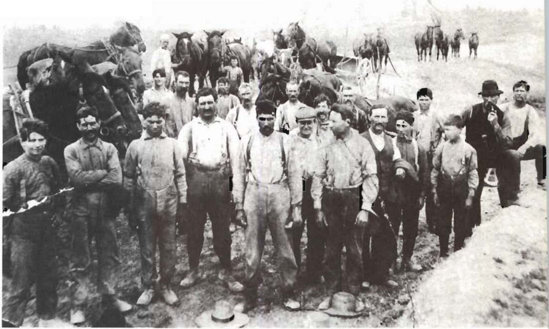
17. Ouvriers affectés à la construction du chemin de fer, Treadwell, 1900.
