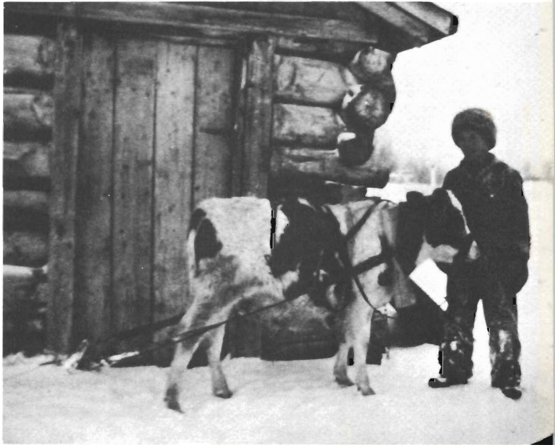
146. École n° 2; livraison du bois de chauffage, Ryland, 1938.
