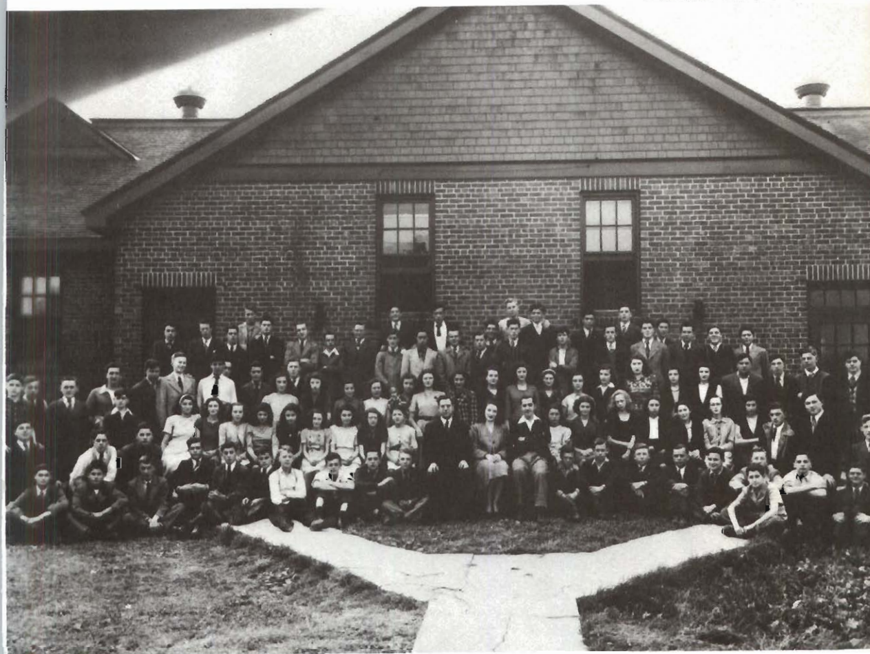
149. École secondaire d'Embrun érigée en 1924, puis rasée par les flammes en 1953. Embrun, s.d.
