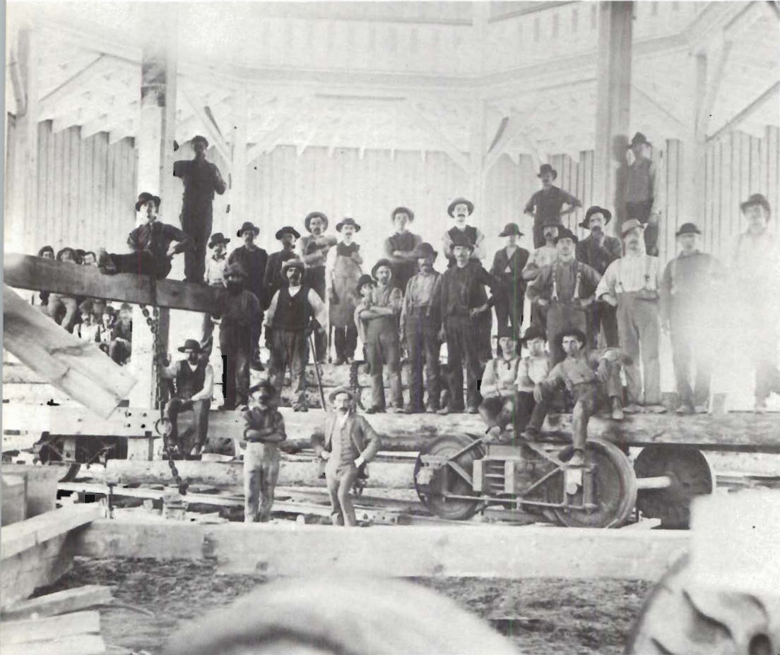
94. Construction du pavillon des expositions au parc Lansdowne, Ottawa, 1888.
