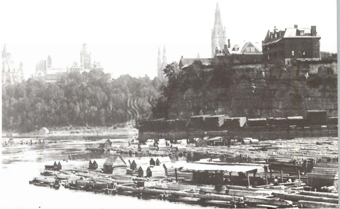
72. «Cages» et «cageux» sur l'Outaouais, Ottawa, env. 1900.
