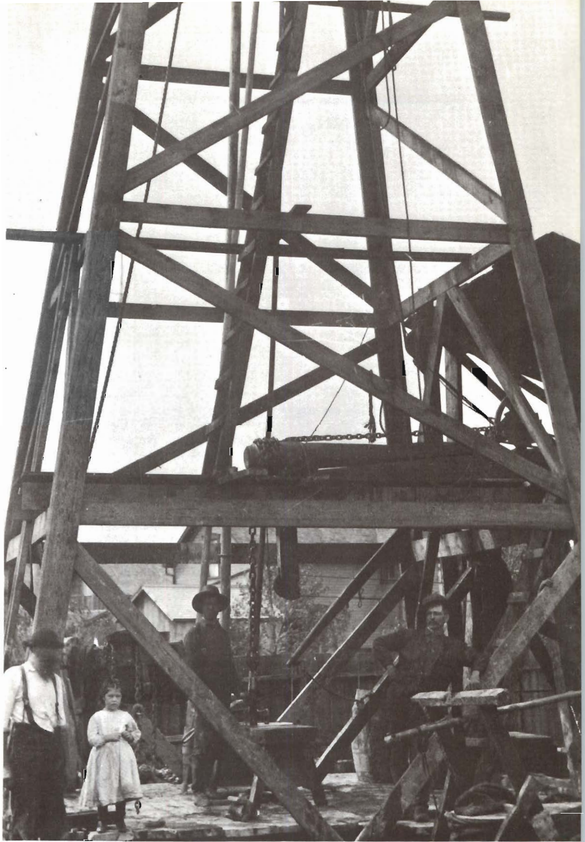
76. Forage d'un puits, Petrolia, s.d.
