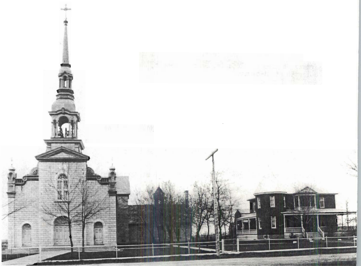
Eglise de St-Albert et le presbytère
