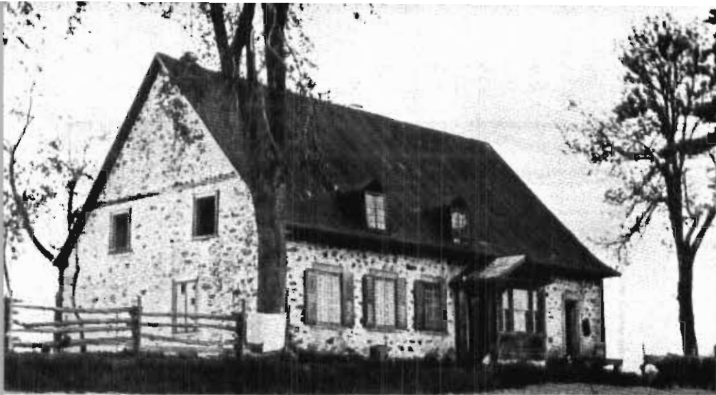
Le presbytère, bâti vers 1696, tel qu'il apparaissait avant les récentes réparations.
