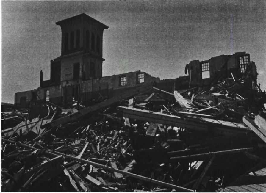
Démolition en 1977 d'une usine de la compagnie Amoskeag qui datait des années 1850. Environ un tiers de ces bâtiments industriels furent détruits entre 1969 et le présent, victimes du "progrès" - Manchester, New Hampshire. Photo Gary Samson.
